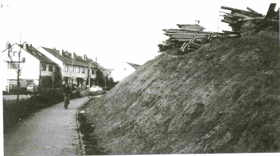
Der Fuß- und Radweg entlang des Zilleringes ist stark frequentiert. Hier fühlen sich jedoch seit einiger Zeit die Passanten wegen der hoch über ihnen drohenden Bohlen, Bretter und Stahlstützen nicht mehr sicher. Mütter mit Kinderwagen meiden bereits diesen Weg, da sie ein Abrutschen des Materials befürchten.
